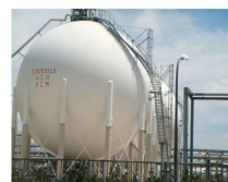
石油化工领域 Petrochemical field
